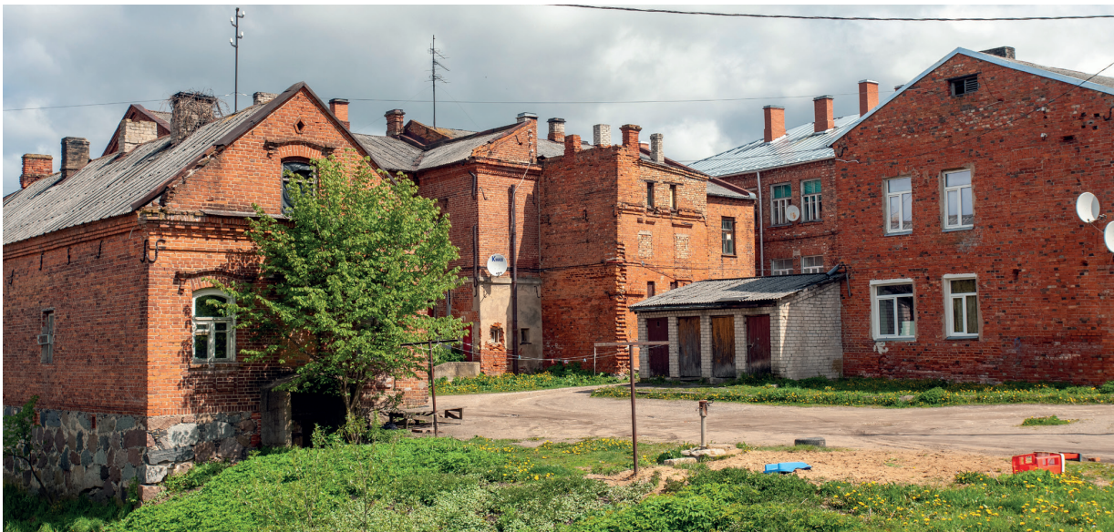
36. attāls. Pogolma apbūve Vacpiļsātā.
